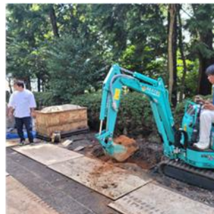
建立工事も見積りいたします。
