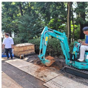
建立工事も見積りいたします。
