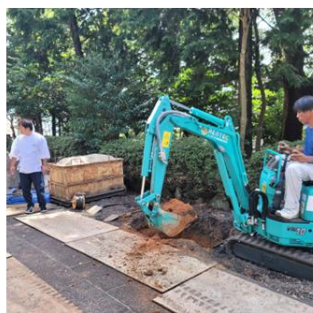
建立工事も見積りいたします。
