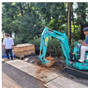
建立工事も見積りいたします。
