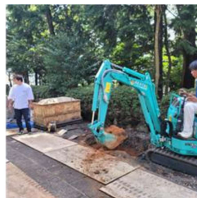
建立工事も見積りいたします。
