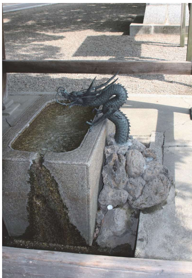
竜の口取付施工例
